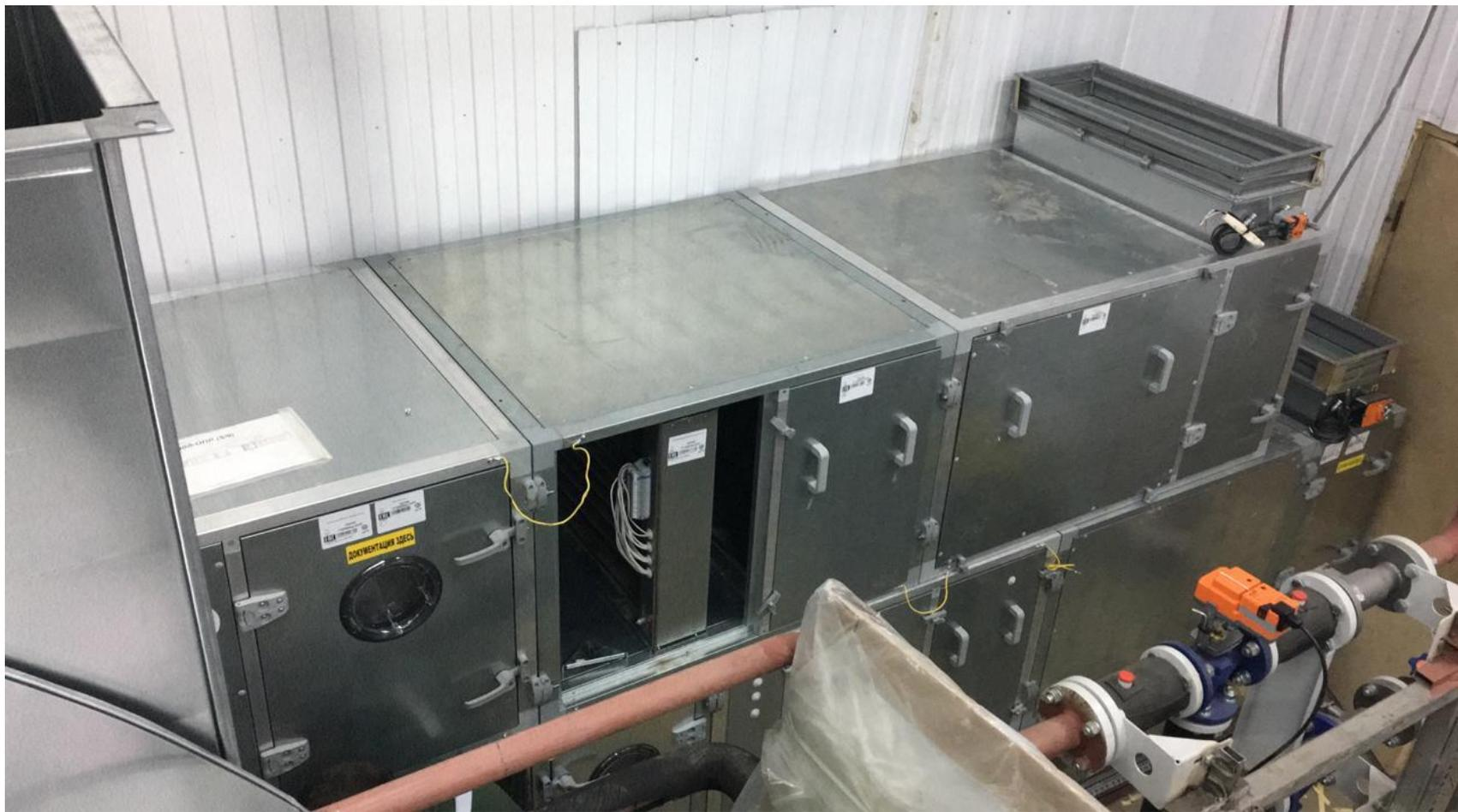
Монтаж вентиляции Онкологического центра. Больница № 63 (2019 год.) Монтаж был произведён в сложнейших условиях (бывшая шахта грузового лифта).
