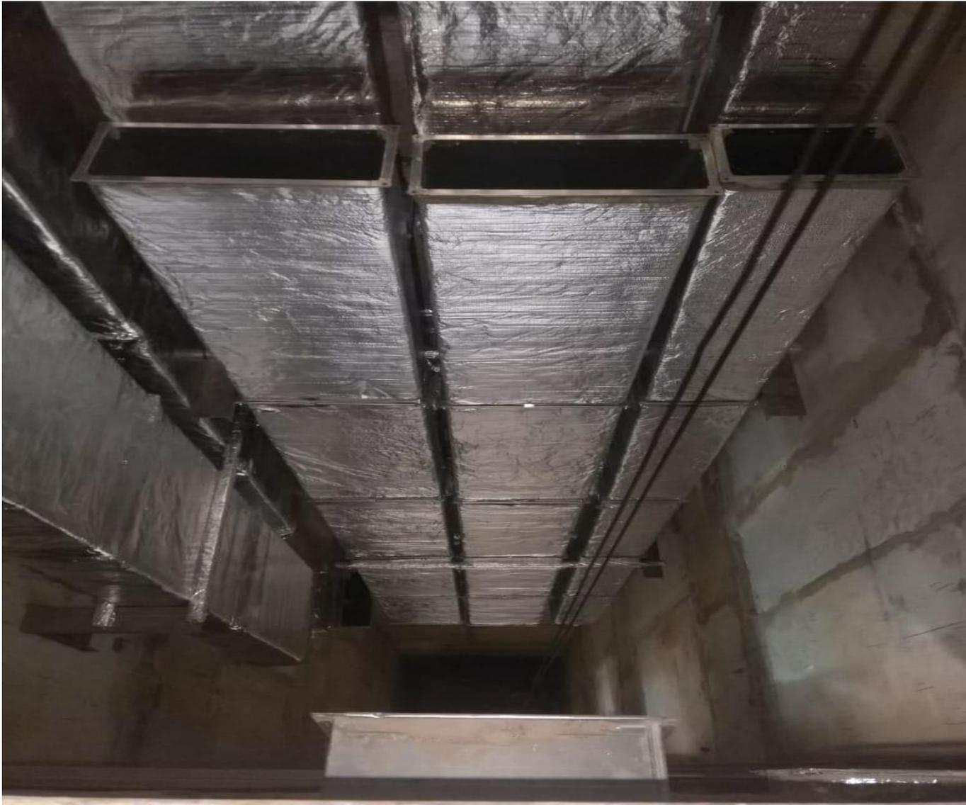
Монтаж вентиляции Онкологического центра. Больница № 63 (2019 год.) Монтаж был произведён в сложнейших условиях (бывшая шахта грузового лифта).
